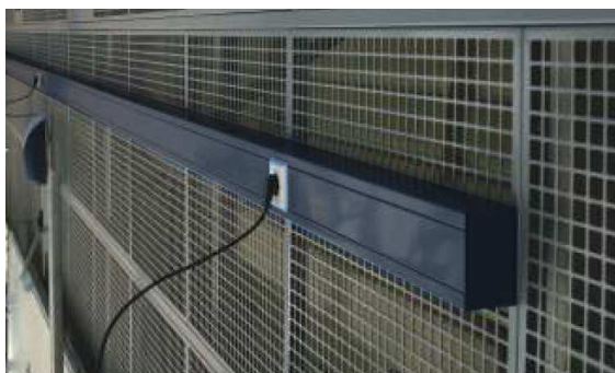
Designový vzor: kanál Strader H68, zásuvky Schneider UNICA TOP alu
